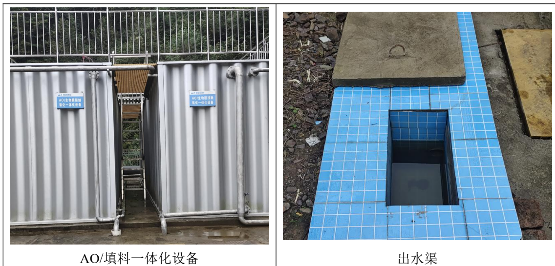
图 3.3-1 五强溪镇南污水处理厂现状图
