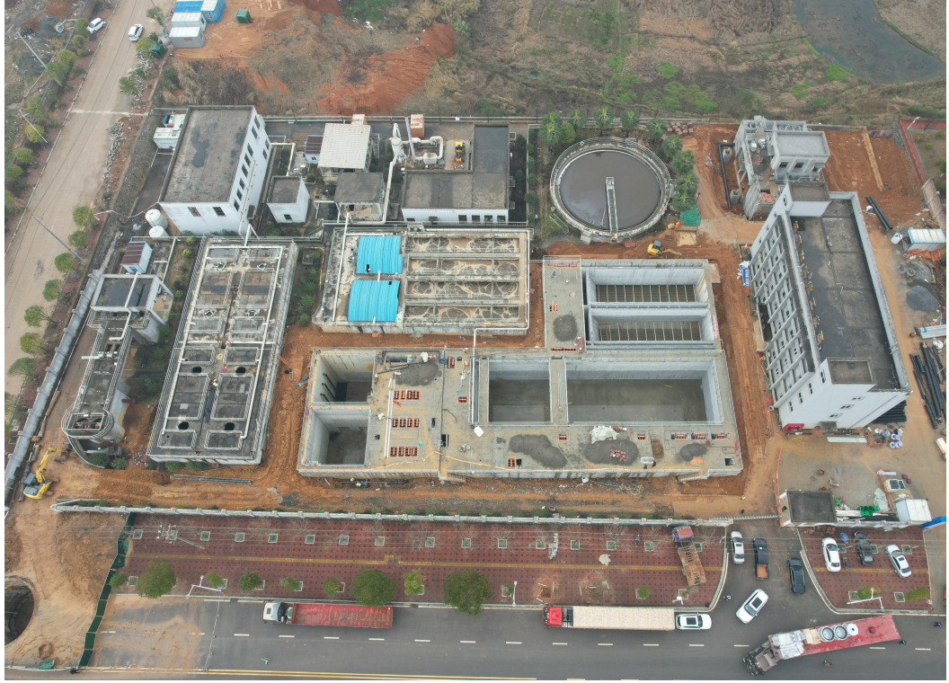
污水处理厂全景
