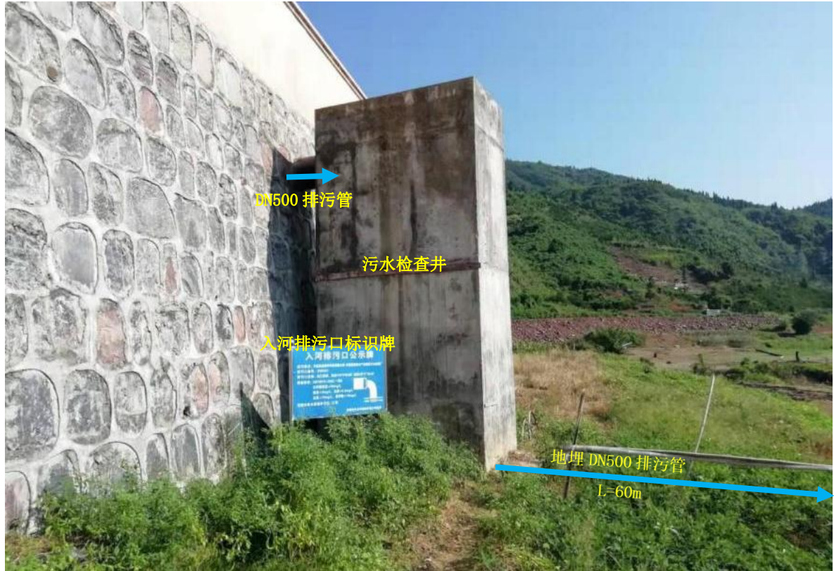
图 5.5-2 入河排污口改建前现场照片
