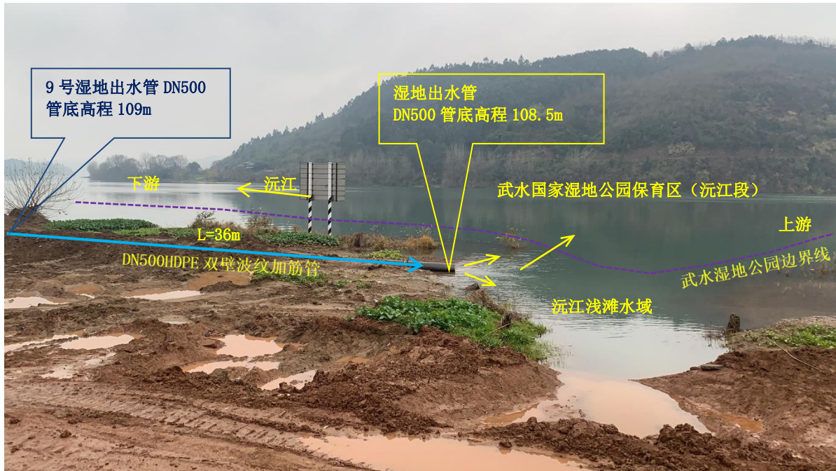
图 5.5-8 湿地进水及湿地出水现状现场照片
