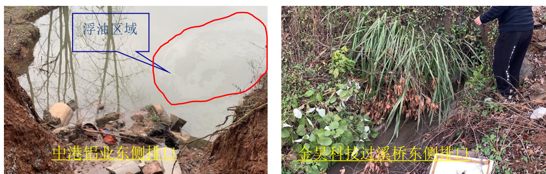
图 2.4-1 工业园区老排口现状照片
