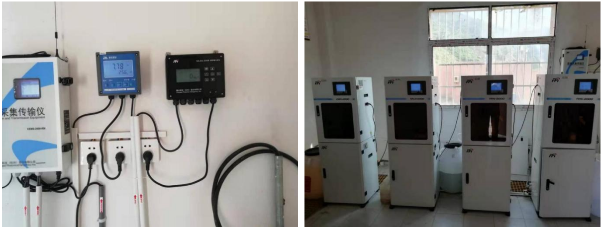
图 8.1-1 数据采集及在线 COD、氨氮、总氮、总磷监测仪
