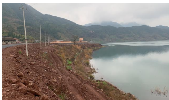
管网沿河铺设
