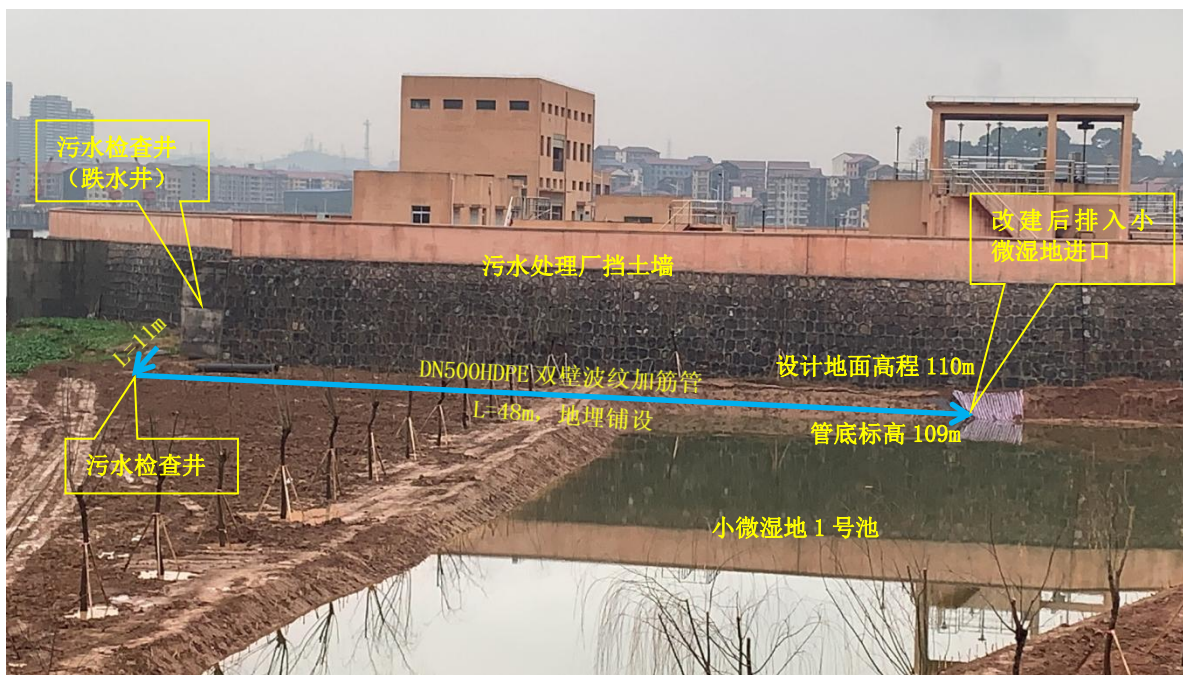
图 5.5-6 入河排污口改建后现状现场照片
