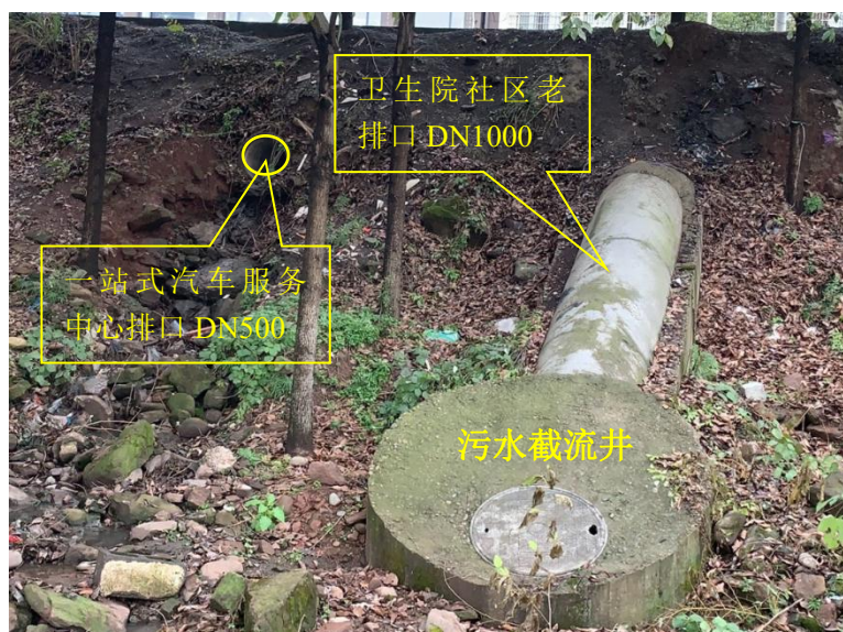
图 2.4-2 一站式汽车服务中心马路对面排口及卫生院社区老排口现状照片
