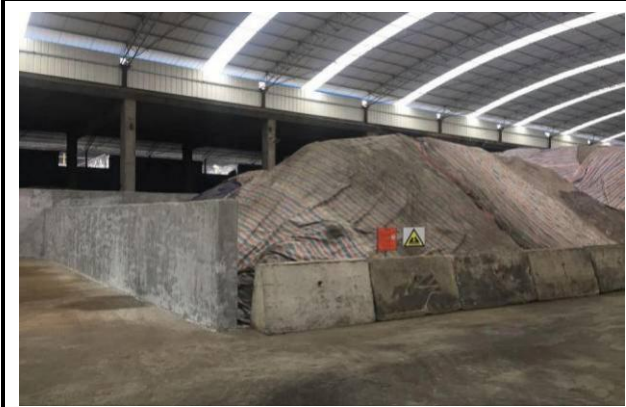
危废渣库分类、分区
