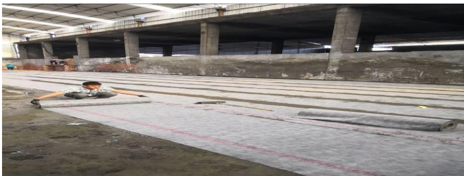
危废渣库防渗施工
