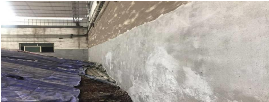
危废渣库，墙裙涂刷的防渗材料
