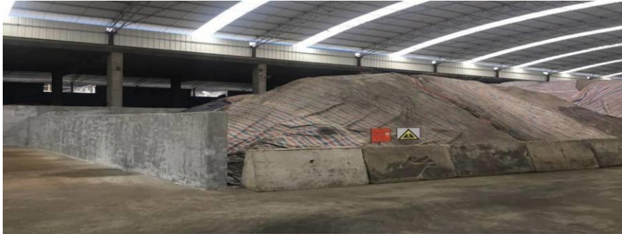
危废渣库，隔墙分类分区堆存，危废标示牌、雨棚、屋顶水雾喷淋)
