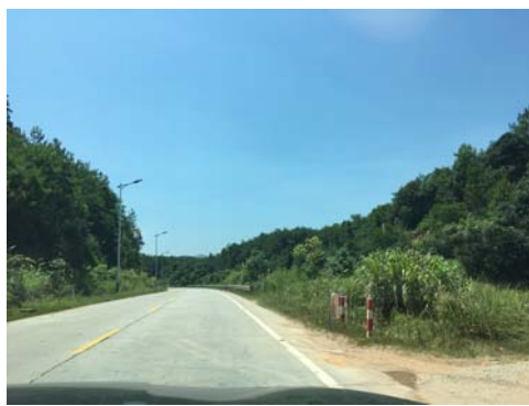
图7-3 公路两侧绿化现状
