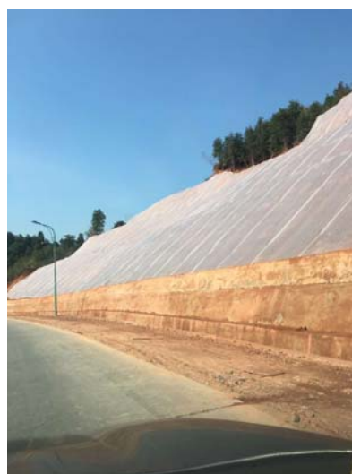
图7-2 公路边坡整改后的形式
