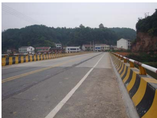
跨水桥梁护栏防护
