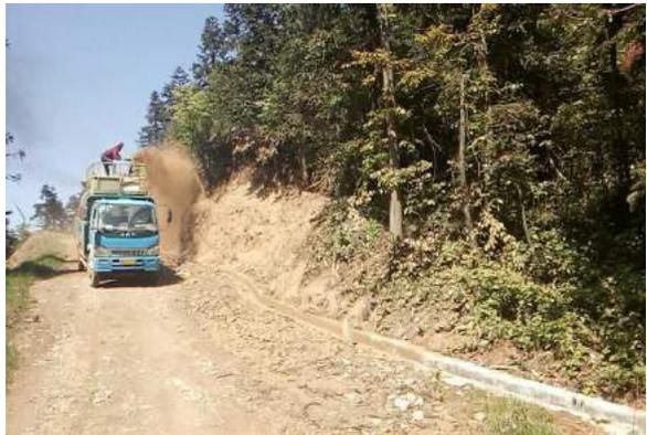
施工作业主路边坡喷播，共4遍。对于石质陡面边坡采取卡草方式加固，防止喷播泥土流失
