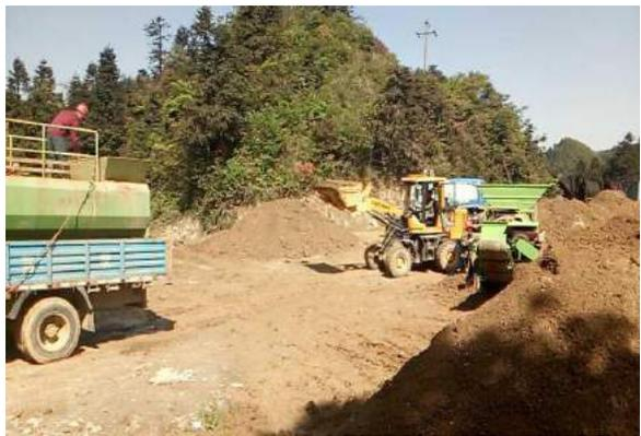
上边坡挂钢丝网、加固，搅拌场筛备好喷播用土，做好施工准备
