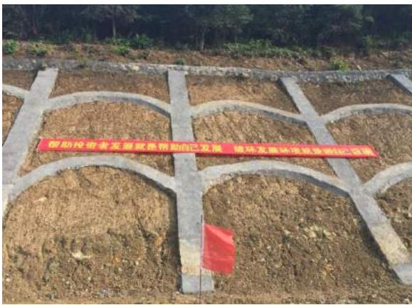
边坡地质构造不稳定处设置格构式挡墙
