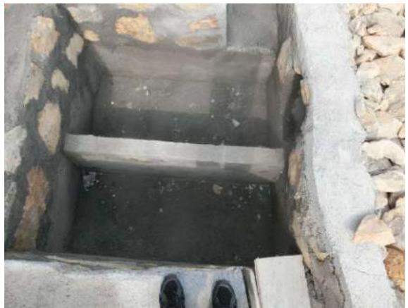
排水沟按规定间隔设置沉砂池，并设置过路段排水涵管
