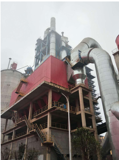
窑尾布袋除尘+脱硝
