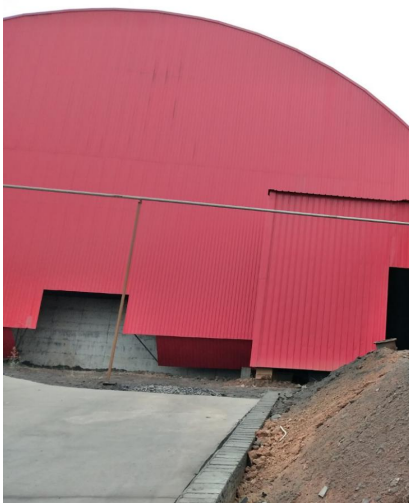
防尘设施（密闭厂房）
