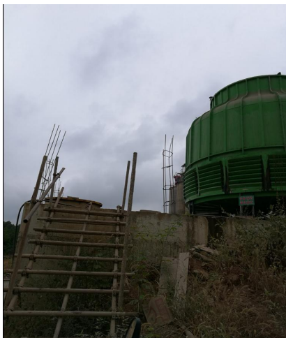
废水防治设施（冷却循环水系统）
