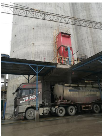
水泥散装（除尘设备）
