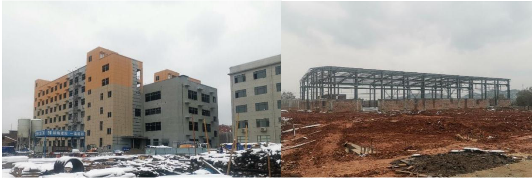
图 3.2-1 永兴县强胜银业有限责任公司 5 万 t/a 电解铅及贵金属综合回收项目场地内现状
