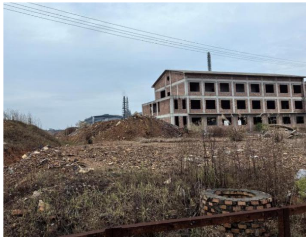
图 3.2-1 湖南省佳之佳环保科技有限公司有价金属废料综合回收改扩建项目场地内现状
