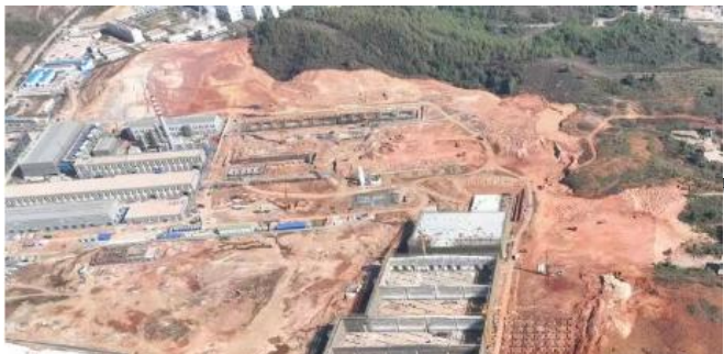
图 5.1.9-3 变更后工程建设情况
