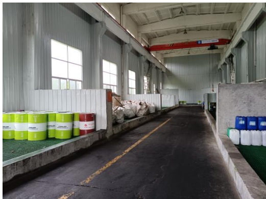
危险废物暂存间（废油漆桶、油桶等）
