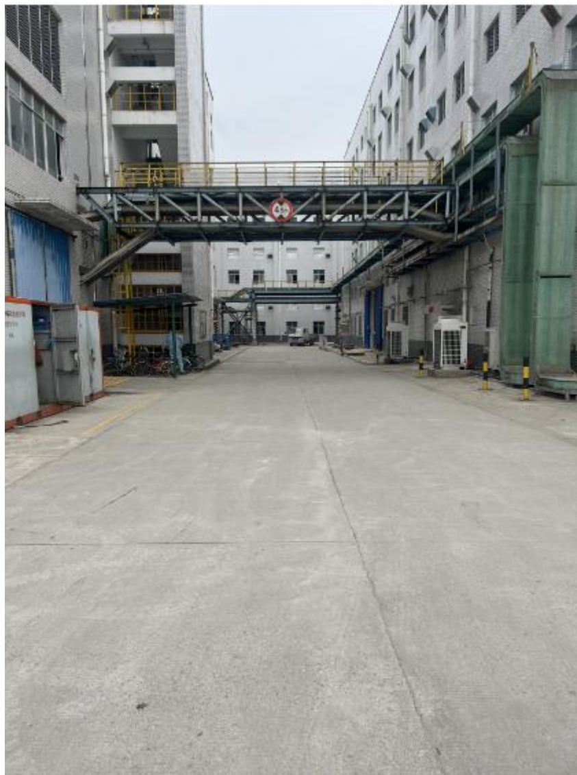
图 1 一车间与二车间之间硬化地面
