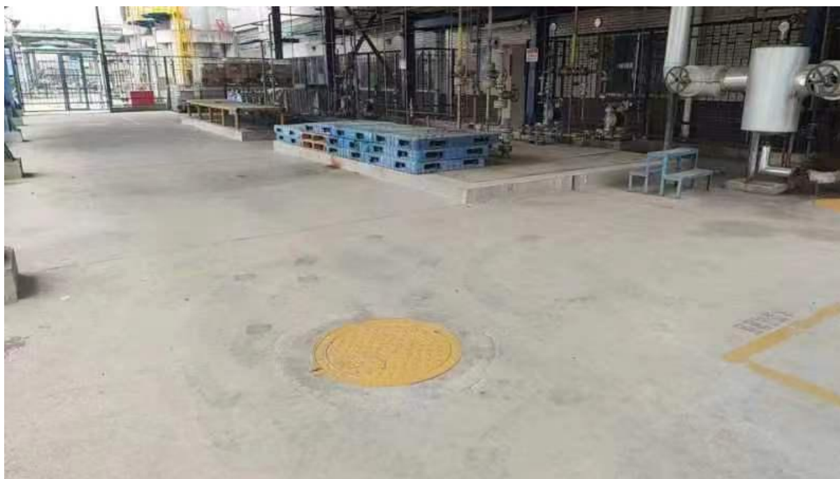
图 3 原料暂存区地面
