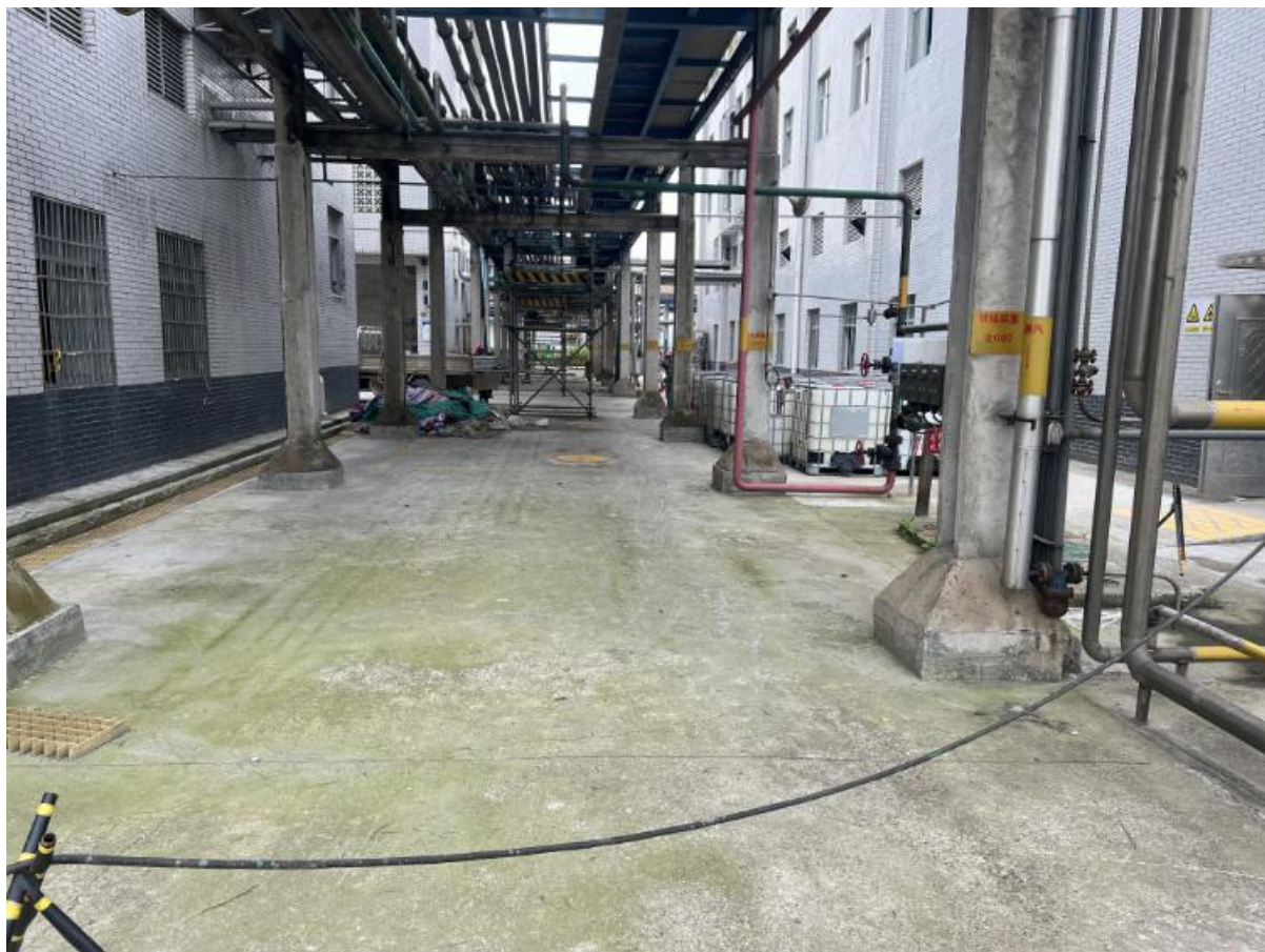
图 2 三车间硬化地面
