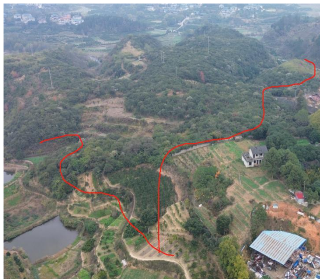
B5 施工便道场地现状
