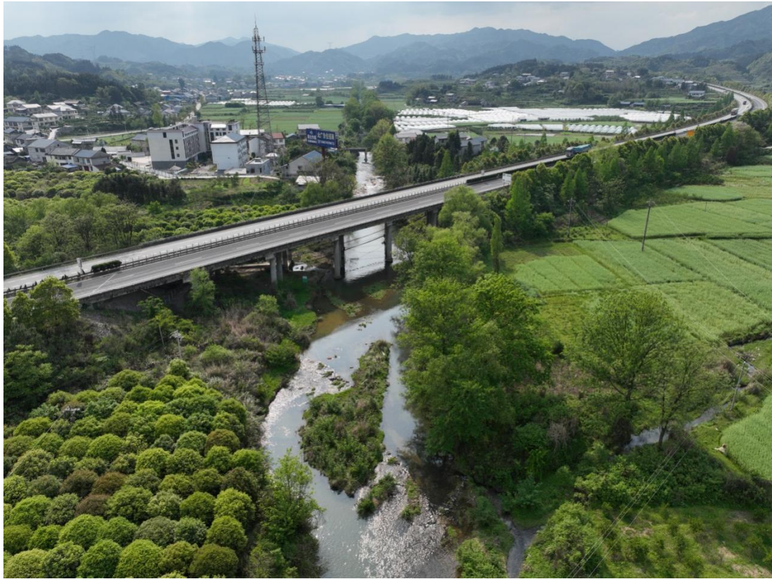
高速公路跨洪溪
