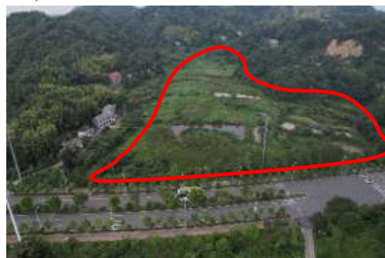
1#弃渣场现状照片
