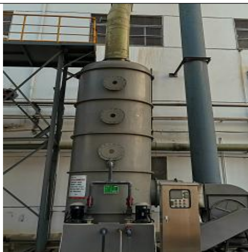
铜铸锭炉废气净化塔
