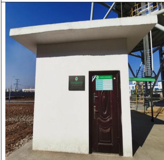
挥发窑及多膛炉除尘脱硫烟气在线系统房
