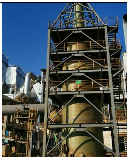
挥发窑开炉烟气洗涤塔
