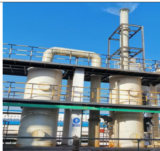
污酸处理蒸发吹脱尾气吸收塔
