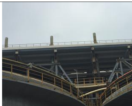
焙砂中浸、亚热酸浸、氧化槽及氧化锌中浸槽废气排气筒
