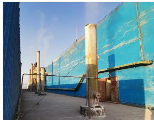
焙砂中浸、亚热酸浸、氧化槽及氧化锌中浸槽废气排气筒
