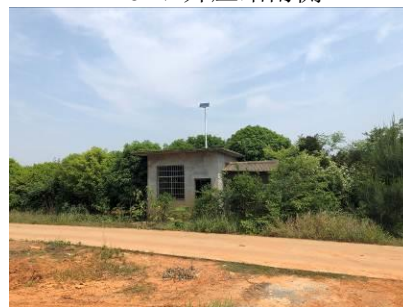
220kV 升压站北侧(废弃看护房)
