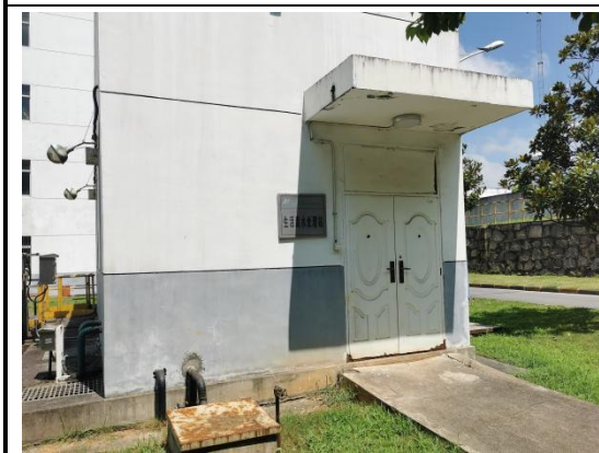
长沙电厂现有生活污水处理站
