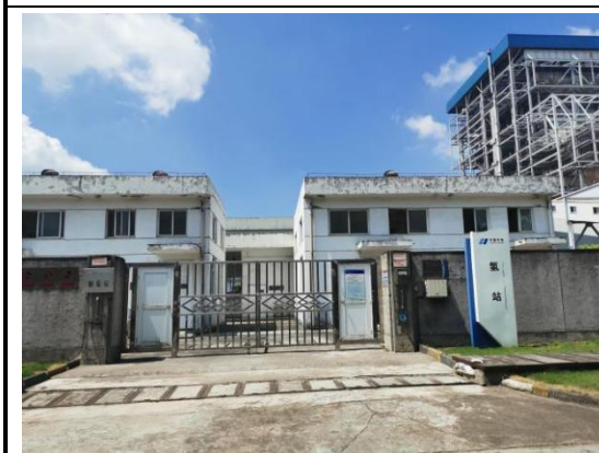
长沙电厂现有制氢站
