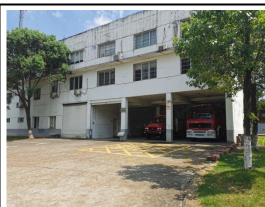
长沙电厂现有消防车库
