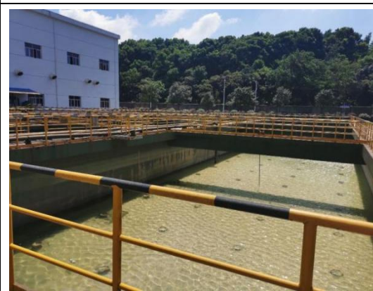
长沙电厂现有工业废水处理站
