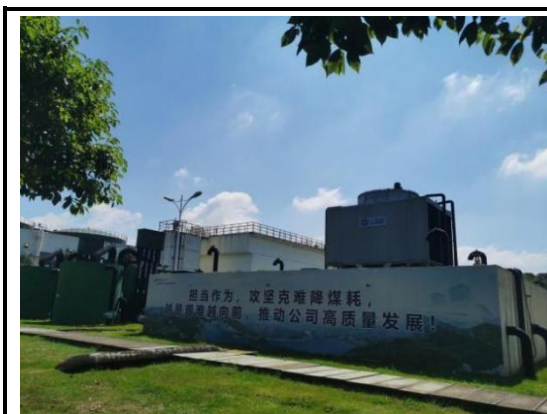
长沙电厂现有消防水泵房
