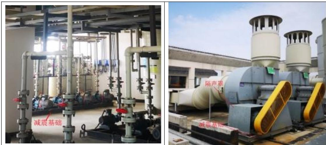
图 2-21 本项目机械旋转设备（部分）隔声、减震措施照片
