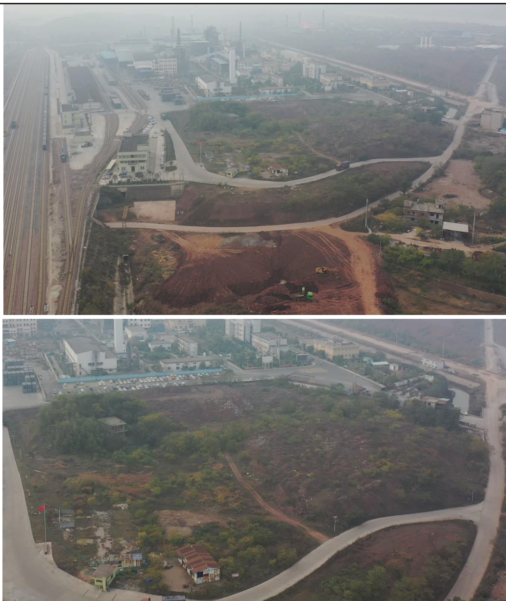
图 3-1 项目现状照片
