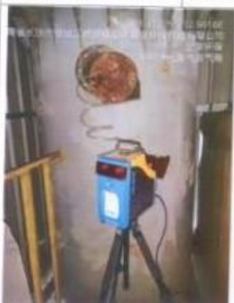
车间净化废气排气筒出口
