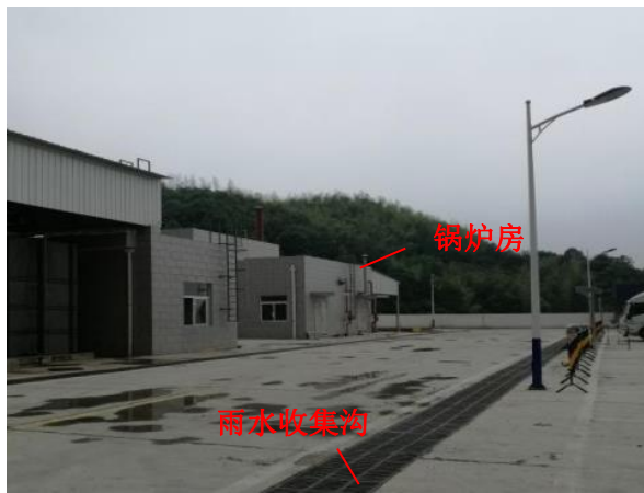
锅炉房和雨水收集沟
