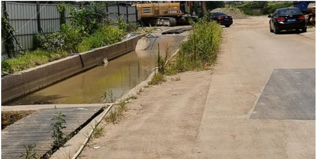
六合岭弃土场出入口洗车平台
