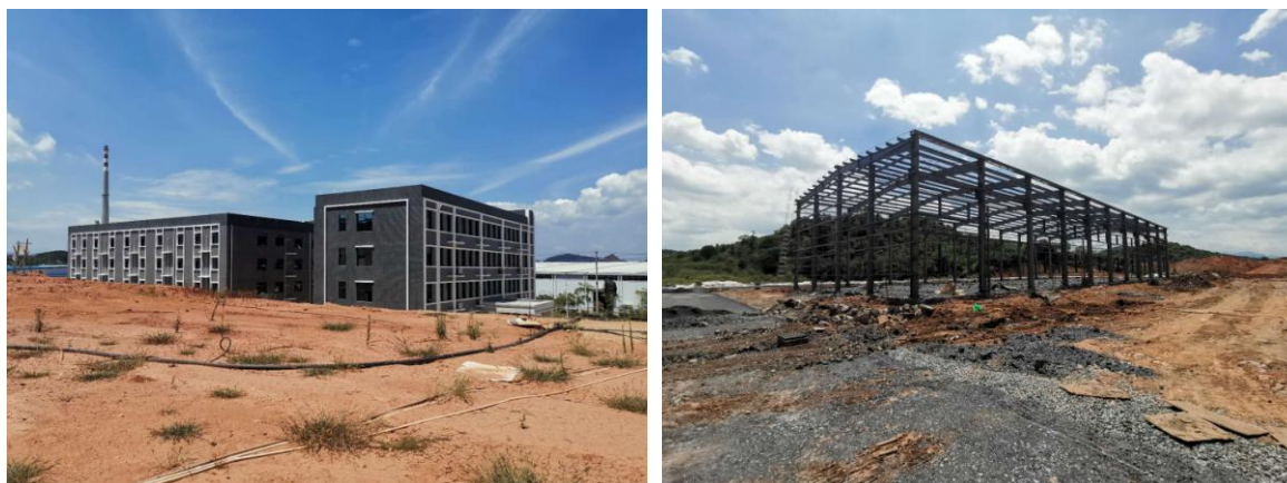
图 3.5-2 办公楼及渣库建设情况
