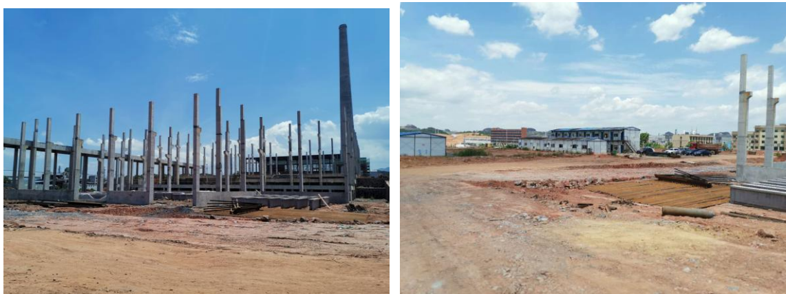
图 3.5-1 工程场地内厂房建设现状
