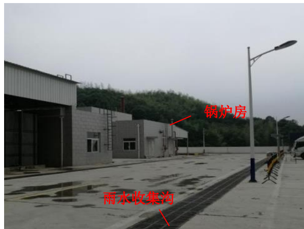
锅炉房和雨水收集沟
