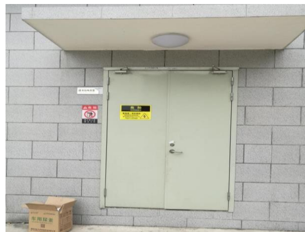
废水处理站电控室
