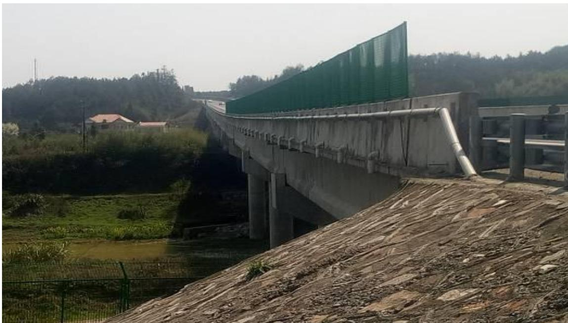
图 7.2-1 桥面径流收集系统现状图
