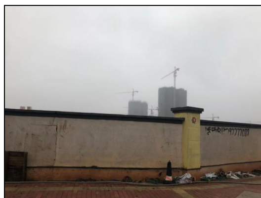
项目西南在建恒大御景天下
