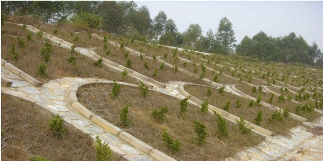
图 1.8-1 骨架护坡
