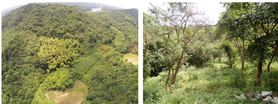
K2+700 左侧弃渣场现状照片
