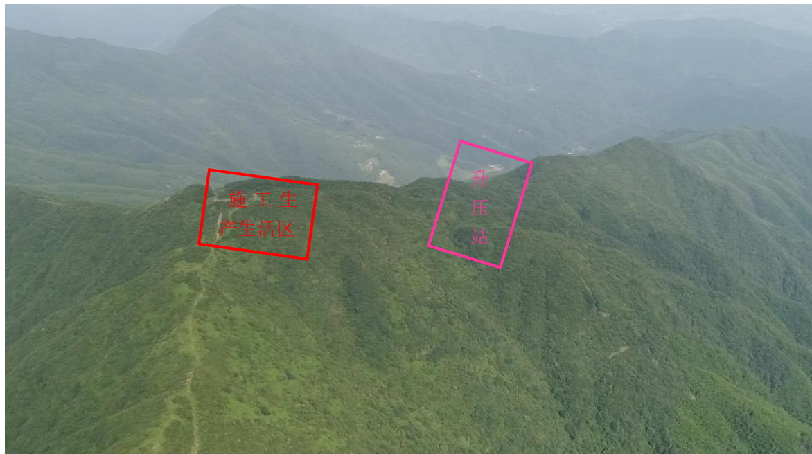
图 1-3 升压站全景图
