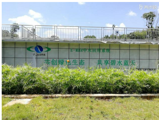
檀山咀服务区污水处理设施
