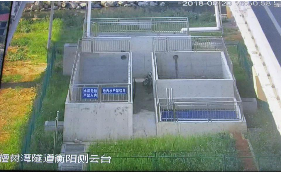
图 8.3-2 侧水大桥应急 I 型处理系统现状图
