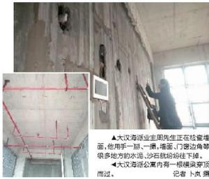
▲大汉海派业主正在检查墙面，他用手一摸，墙面门边边角有很多地方的水泥、沙石就纷纷往下掉。
