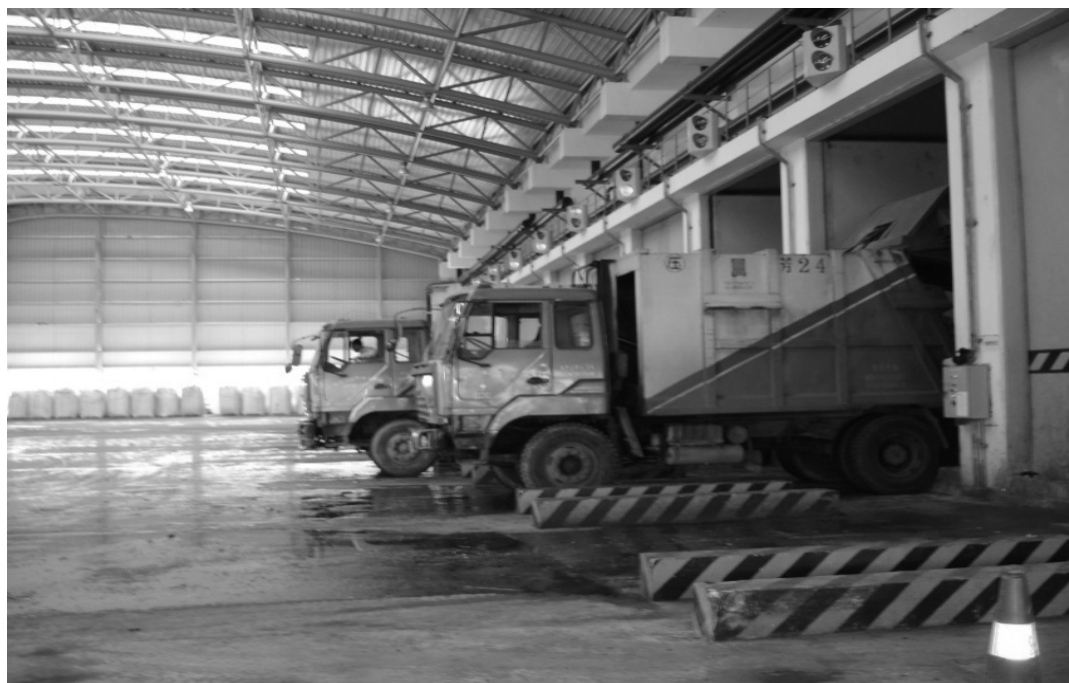
图 4.4-1 垃圾卸料大厅
