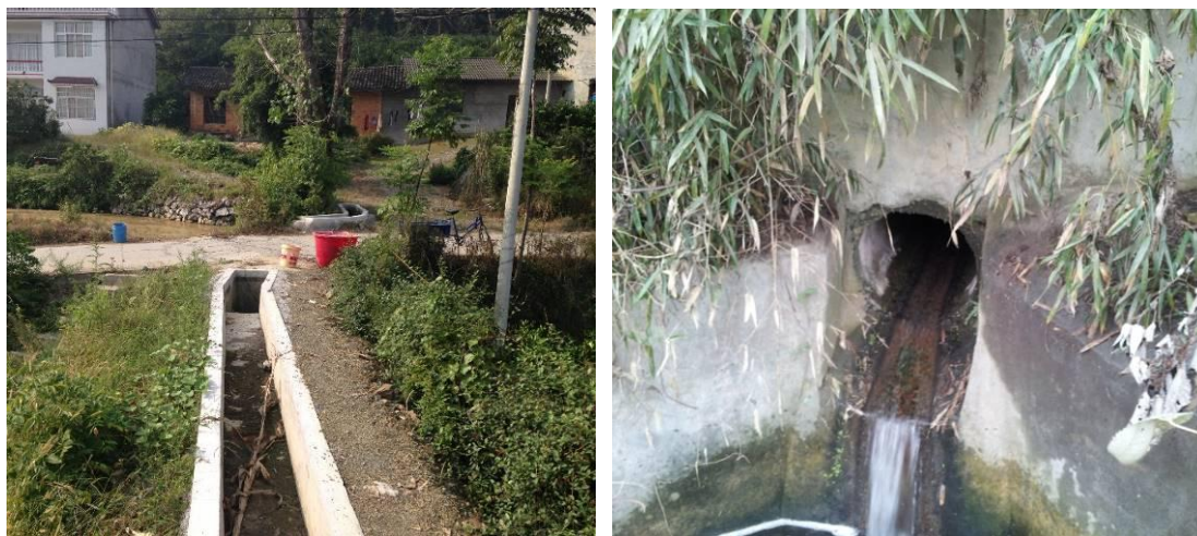
图 2.1-3 老路涵洞现状
