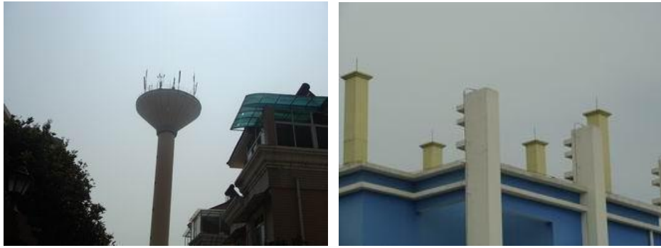
图 3-9 城市中基站典型的天线架设方式
