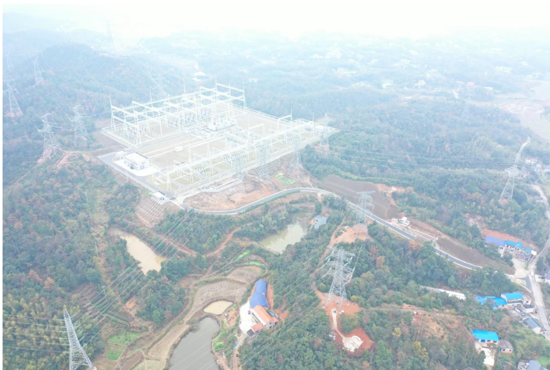
图 4-1 安宁 500kV 变电站区域地形地貌航拍图
