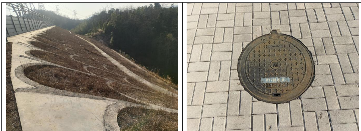
图 3-5 安宁 500kV 变电站外护坡绿化及排水
