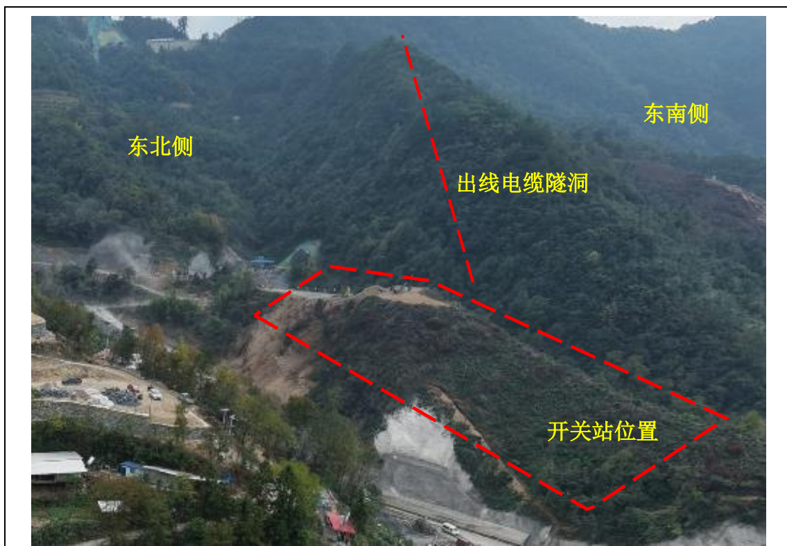
开关站、出线电缆隧洞现状及周边
