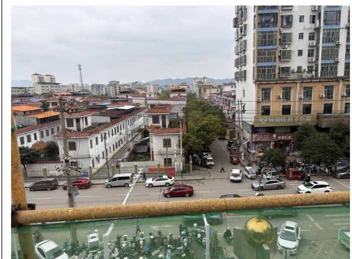
放疗中心大楼西侧现状
