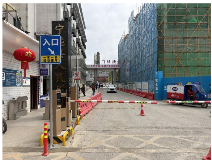
放疗中心大楼北侧现状
