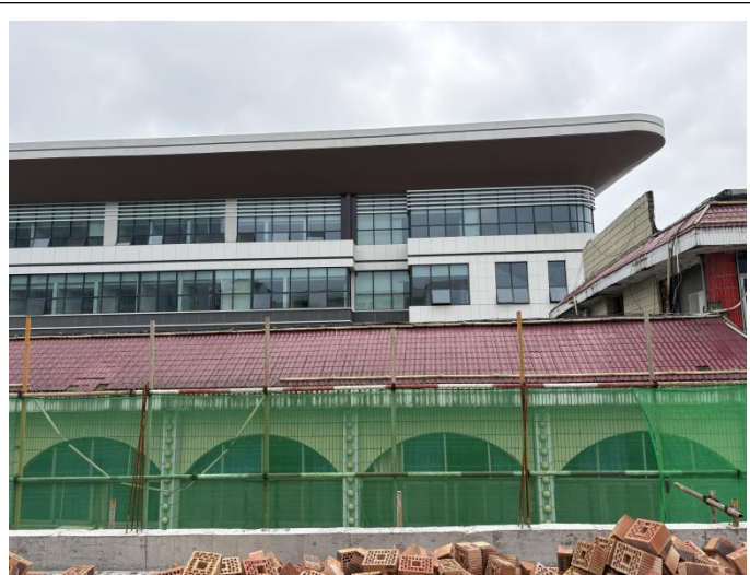
放疗中心大楼南侧现状
