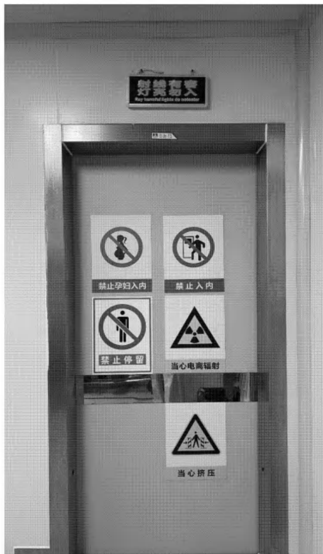
附件 3: 整改后辐射场所警示灯
