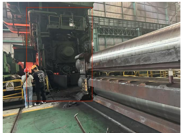
测厚仪拟安装位置东南侧精轧机
