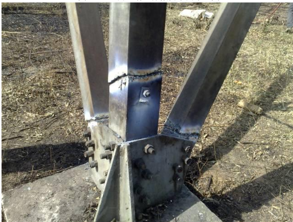
图 3-11 塔腿主材及八字铁切割工程实景图
