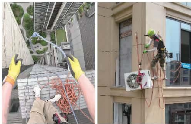
赵亮正在进行高空作业。
