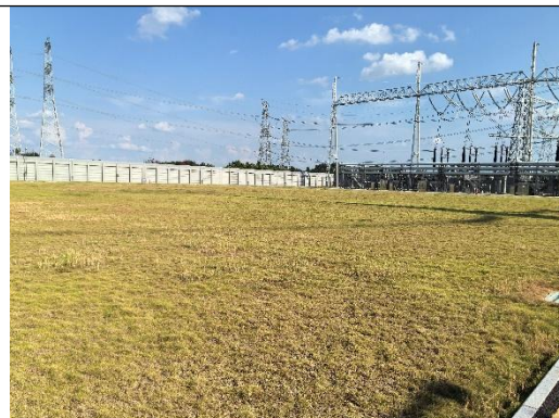
本期拟建主变位置
