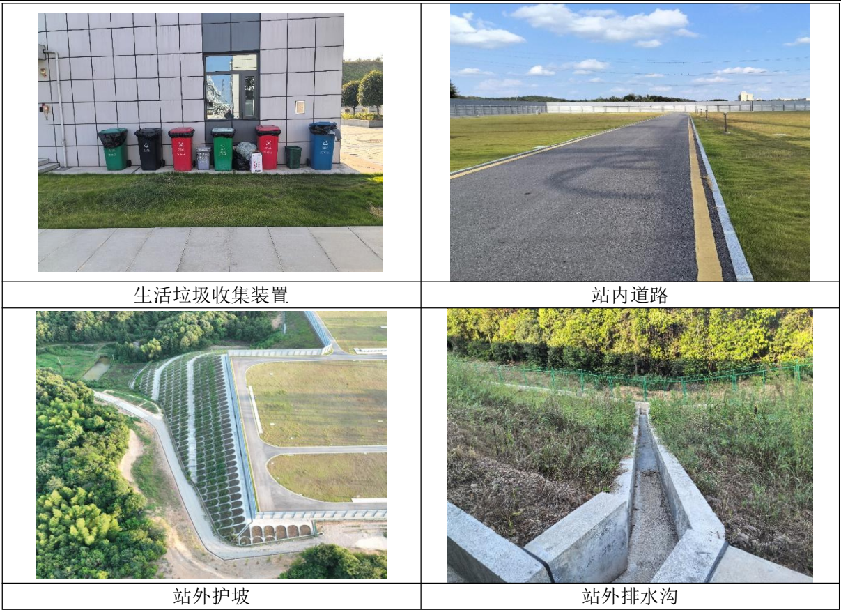
图 3-3 本工程变电站实景照片
