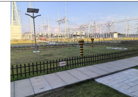
主变事故油池
