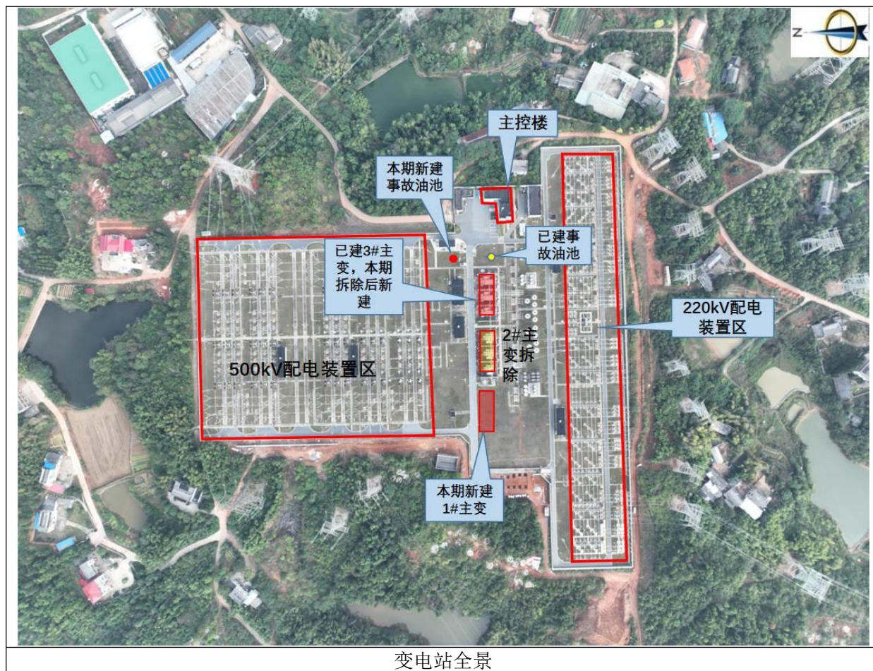
图 3-1 鹤岭 500kV 变电站现状情况
