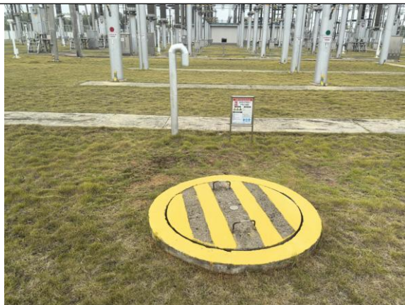
主变事故油池
