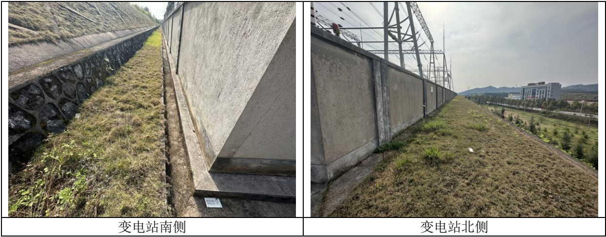
图 4-1 苏耽 500kV 变电站站址现状照片
