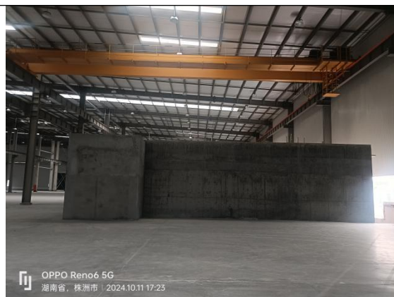
加速器机房南侧
