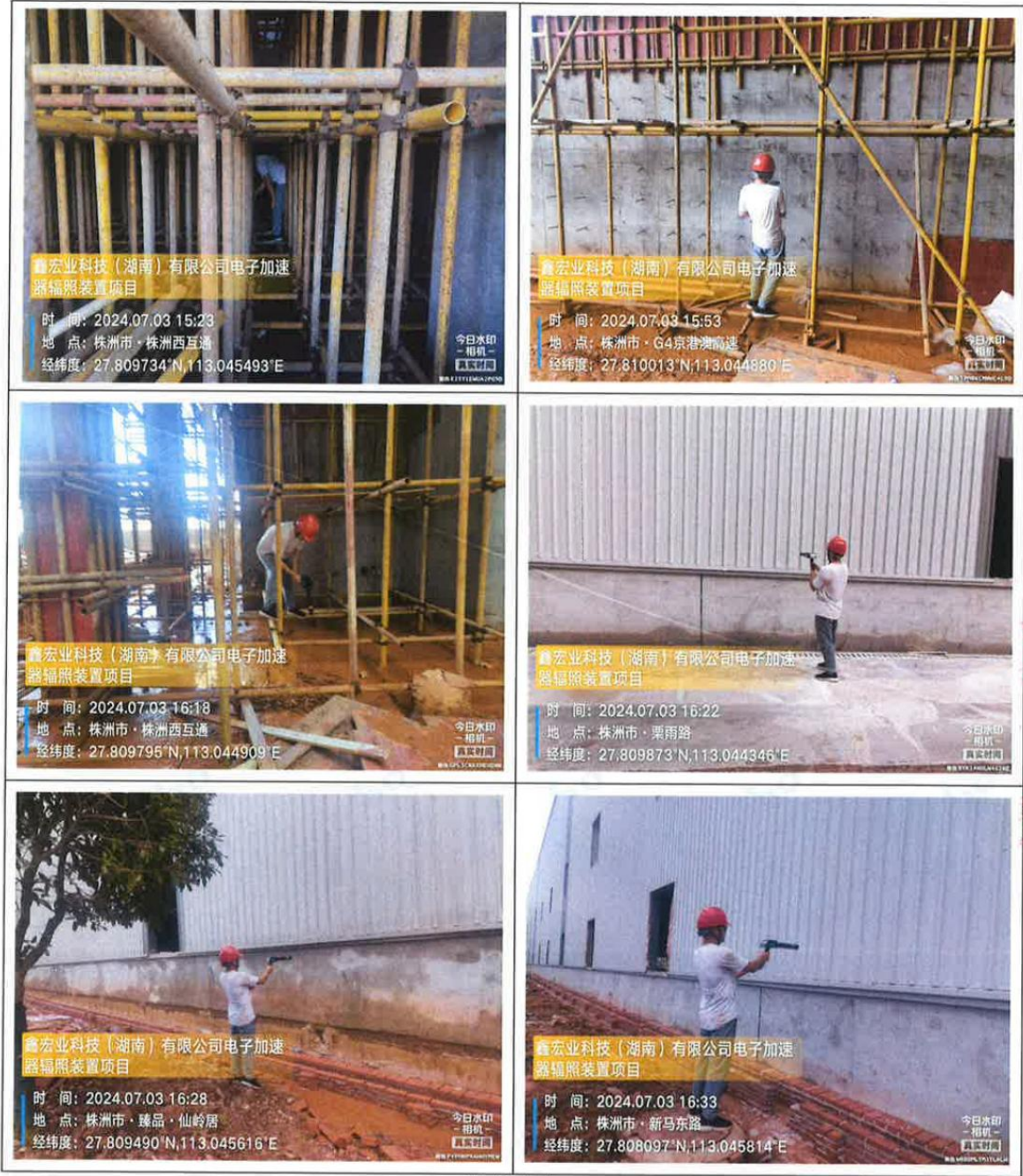
附图 2 现场检测照片
