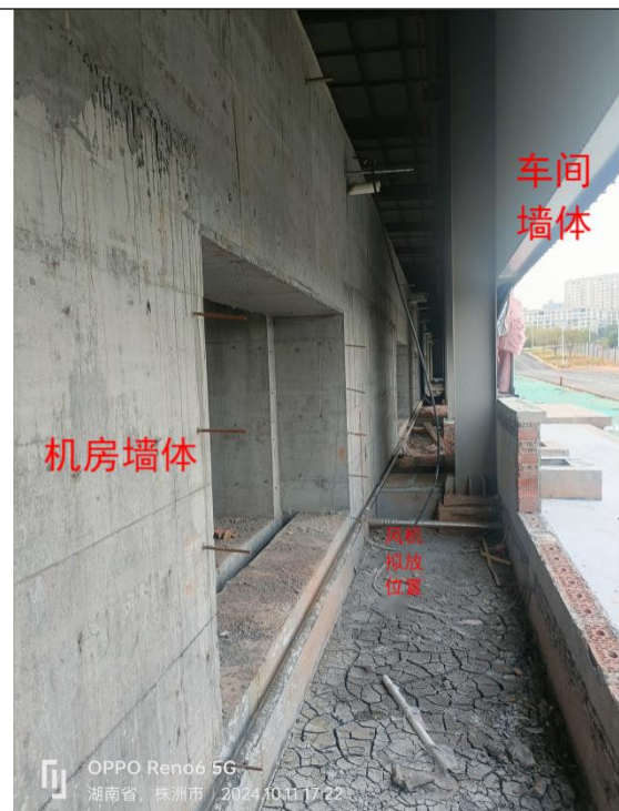
加速器机房东侧（暂未封闭）
