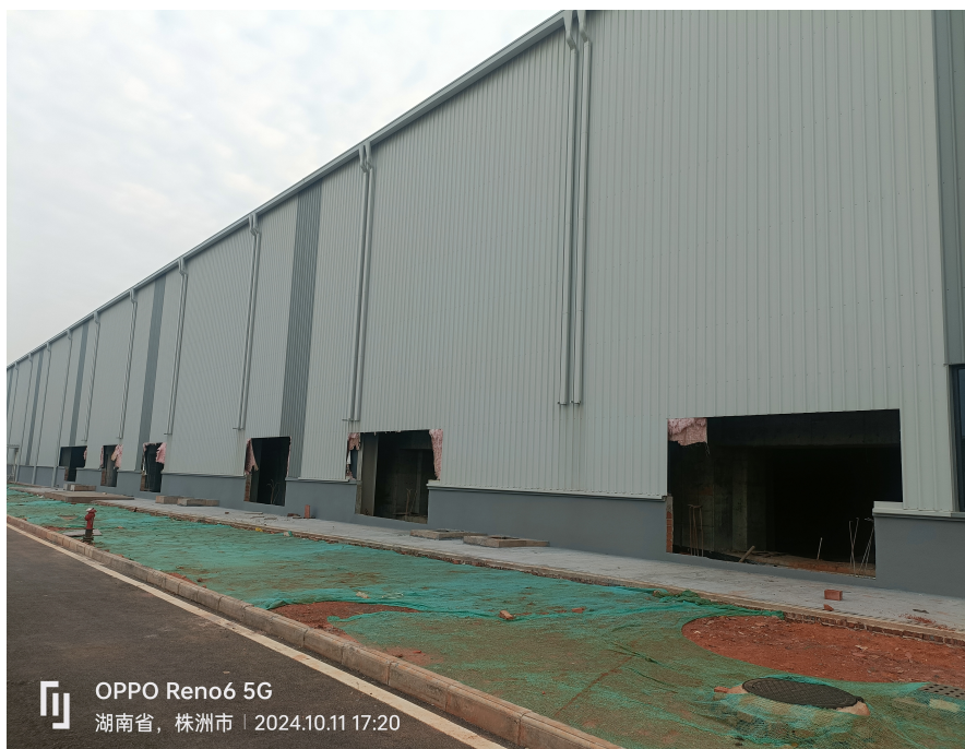
辐照室所在线缆生产车间东墙外现状
