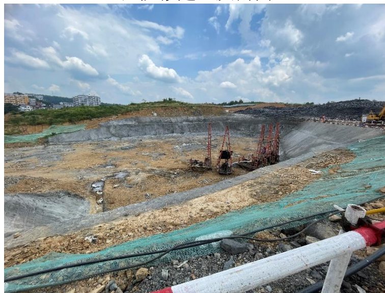
直加机房拟建地（基坑）
