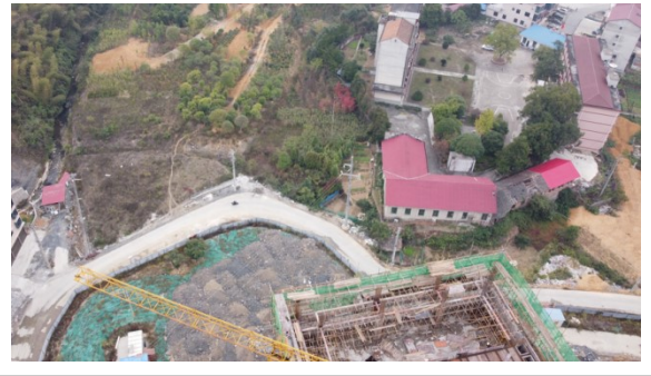
住院楼、门急诊医技综合楼西侧
