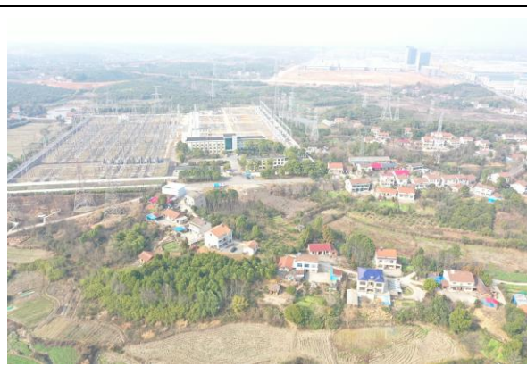
岗市 500kV 变电站周边概况
