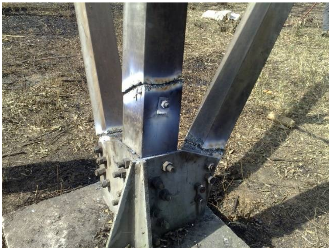
图 3-6 塔腿主材及八字铁切割工程实景图
