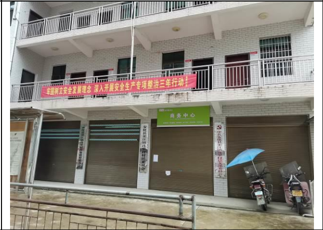
益阳市安化县渠江镇连里村
