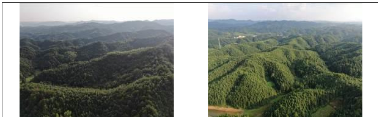
图 4-1 平江 500kV 开关站站址现状照片
