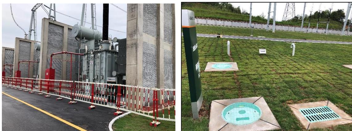
图 3-2 浏阳 500kV 变电站内主变压器下方卵石层及事故油池
